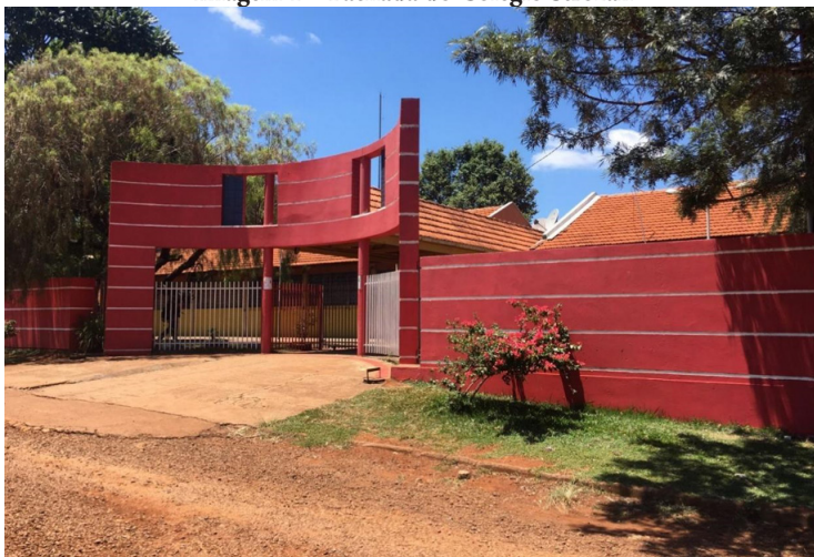
Imagem 1 – Fachada do Colégio Strozak
