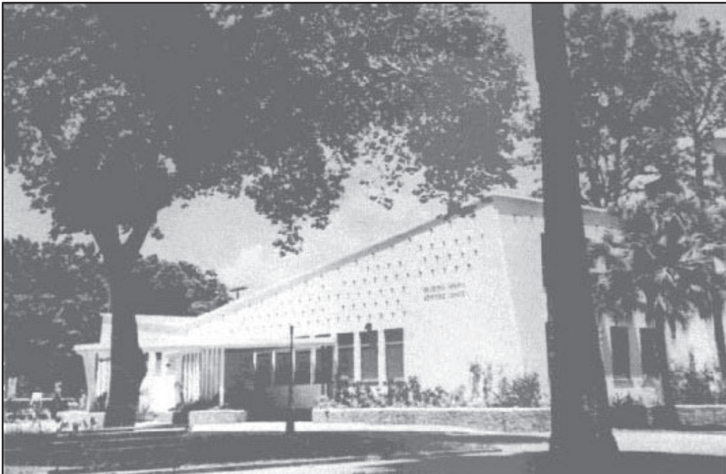
Figura 6: Segunda Casa da BIML - prédio em substituição à casinha anterior, desativado por defeitos estruturais (1954-1962)
