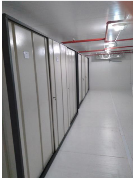
Figura 6: Parte interna da Câmara Fria do Arquivo IEB – USP.
