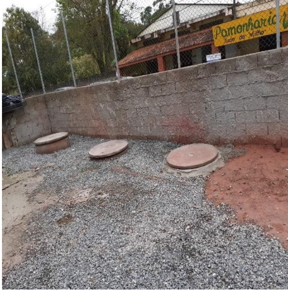
Figura 03 – Construção da fossa biodigestora
