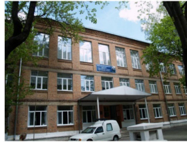
Fachada da Escola 4 Kharkov
